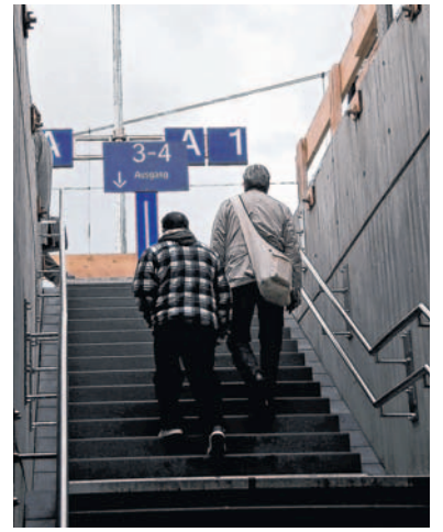
Hier geht's hoch: Treppenaufgang zu den Gleisen eins und zwei.
