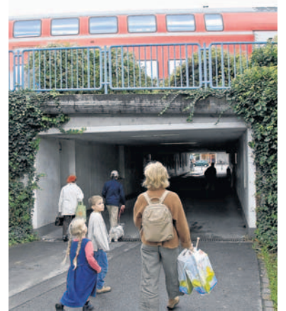
Hier gehts rein: Unterführung Schwanheimer Straße.
